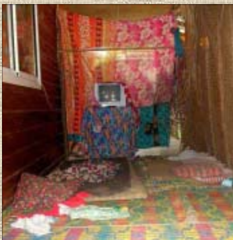
Le sol est couvert de fibres d'amiante (trémolite). Il est le lieu de nombreuses activités : regarder la télévision, papoter, faire des devoirs... (Photo Emmanuelle Marquette)
