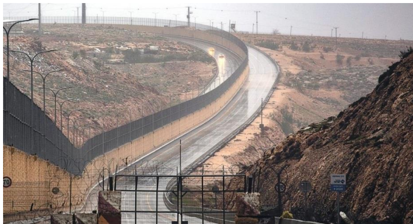
Nouvelle route de l'apartheid inaugurée le 10 janvier 2019 en Cisjordanie occupée, au Nord Est de Jérusalem
